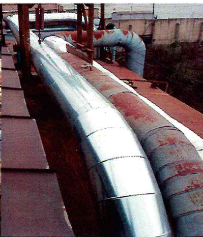
Фото 2.2. – Паропровод (участок «галерея в осях 10-14»)
