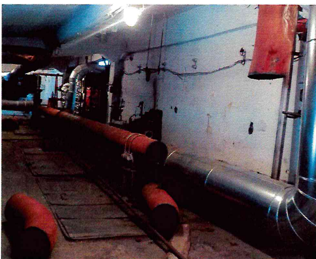
2.12 – Демонтаж паропровода 2-й очереди
