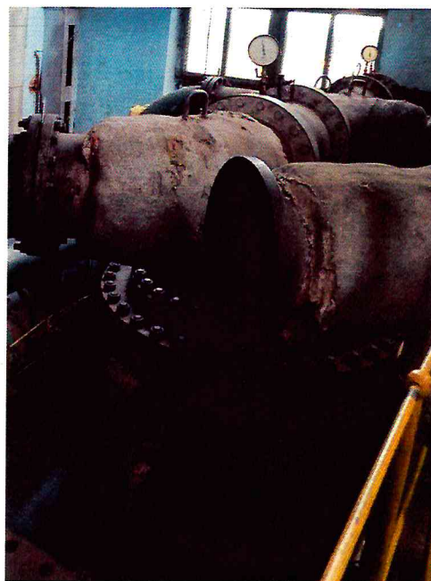
Фото 4.3, 4.4 – подогреватель сетевой воды №2 (ПСВ-315-14-23) введен в эксплуатацию.
