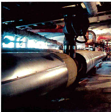
Фото 2.1 – Паропровод (участок «галерея в осях 7-10»)
