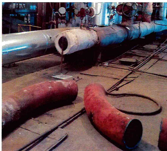
Фото 2.10, 2.11 – Паропровод 1-я очередь (диаметром 273 мм) введен в эксплуатацию
