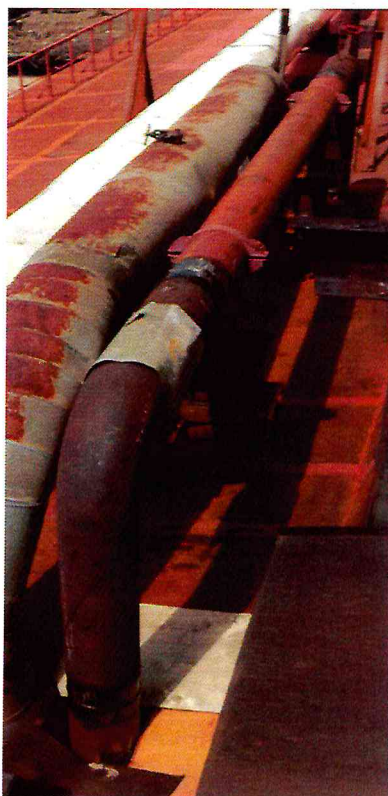
Фото 2.6 – Паропровод (участок «галерея в осях 5-6»)
