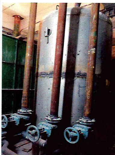
Фото 6.2, 6.3, 6.4. – Монтаж фильтра катионидного в здании ТЭЦ участок химводоочистки.
