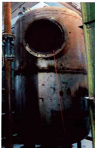
Фото 6.2, 6.3, 6.4. – Монтаж фильтра катионидного в здании ТЭЦ участок химводоочистки.
