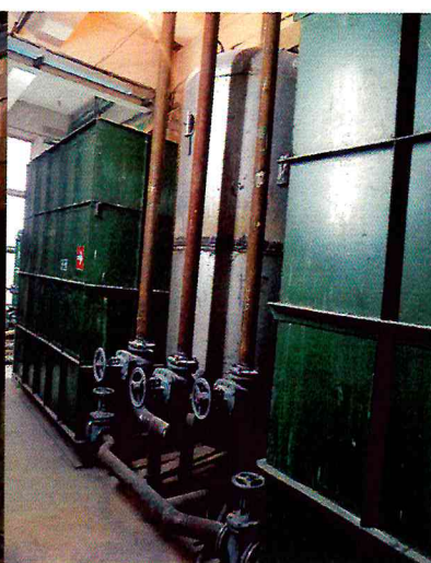
Фото 6.2, 6.3, 6.4. – Монтаж фильтра катионидного в здании ТЭЦ участок химводоочистки.
