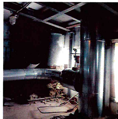
Фото 2.3 – Паропровод (участок «сухой откос»).
