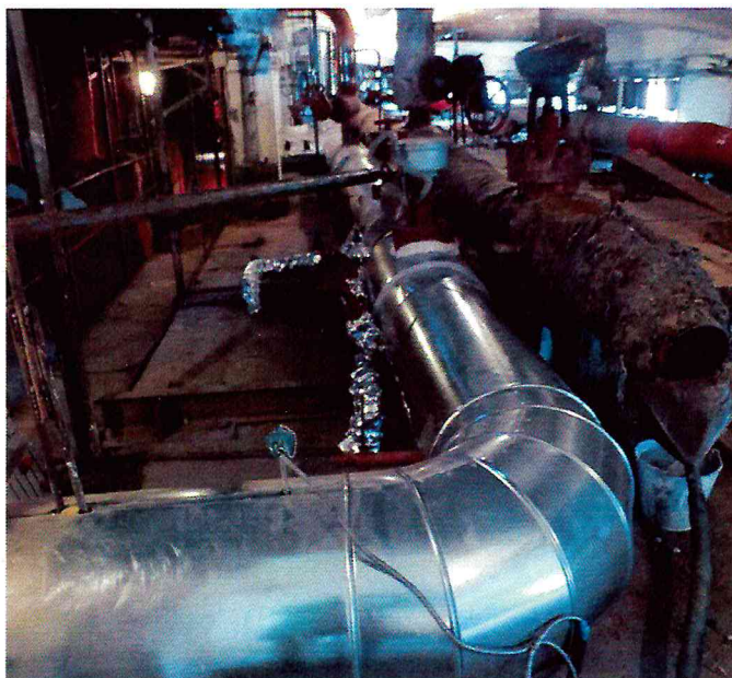
Фото 2.10, 2.11 – Паропровод 1-я очередь (диаметром 273 мм) введен в эксплуатацию
