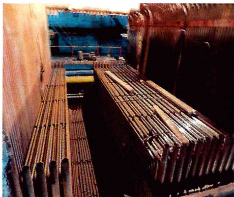
Фото 5.1 - Монтаж полусекций на водогрейном котле КВГМ-100 №2
