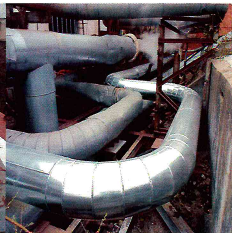
Фото 2.3 – Паропровод (участок «сухой откос»).
