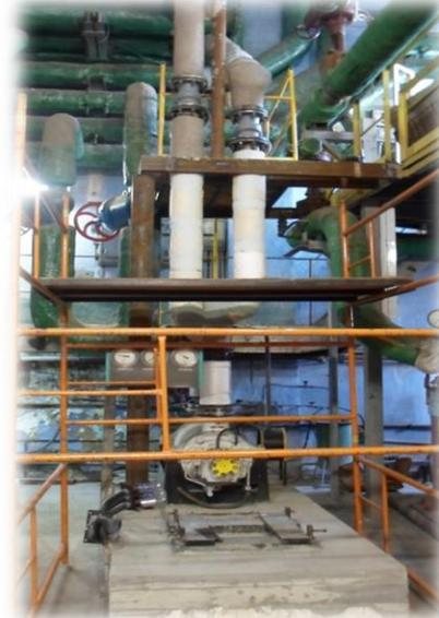
Установка подогревателя сетевой воды в ТЭЦ для теплоснабжения потребителей
