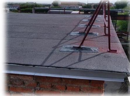
**Организация РТХ: трубопровод технической воды для нужд пожаротушения**
