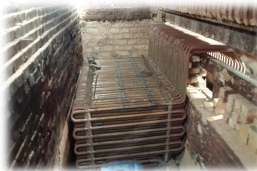
Реконструкция пароперегревателя парового котла №1
