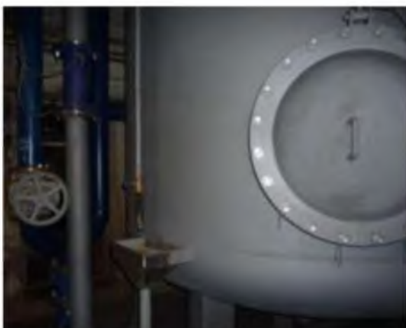
Фото 7.1. –Механический фильтр №4
