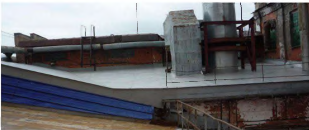
Фото 18.1. Реконструкция здания котельной цеха (котельный участок ТЭЦ)
