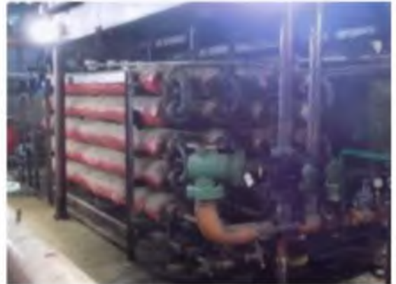
Фото 4.1., 4.2. - Перевод технологии подогрева мазута с пара на горячую воду.
