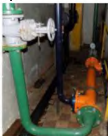
Фото 15.1. Модернизация пароструйного эжектора с трубопроводами обвязки.
