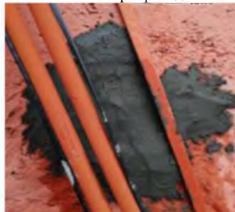
Фото 3.2. – Восстановление защитного слоя бетона безусадочной смесью
