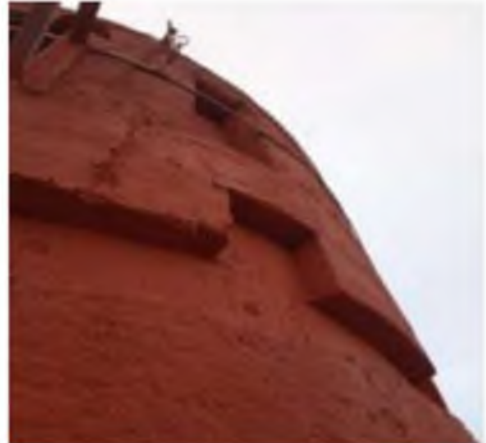
Фото 3.4. – Восстановление бетона и окрасочного покрытия оголовка
