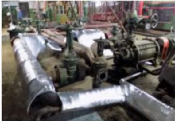
Фото 4.1., 4.2. - Перевод технологии подогрева мазута с пара на горячую воду.
