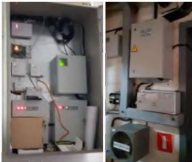
Фото 16.1. Организация безопасности и антитеррористической защищенности объекта ТЭЦ. Система охранно-пожарной сигнализации ТЭЦ.
